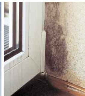
Formazione di muffa a causa di aerazione insufficiente.
